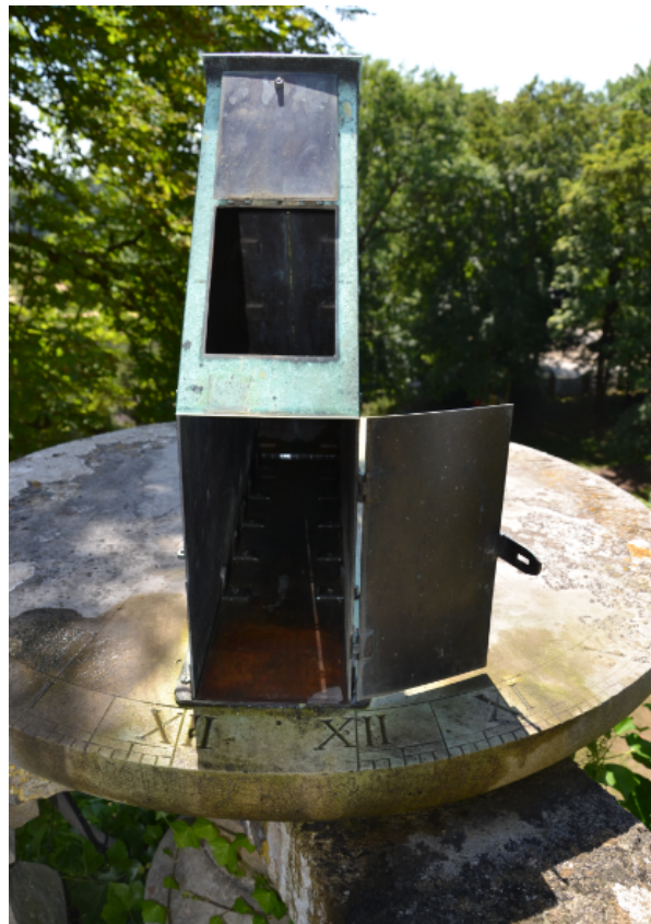
Fig 4 : Trente minutes avant midi solaire, on commence à distinguer le rai de lumière à l'intérieur de la chambre méridienne. ►
