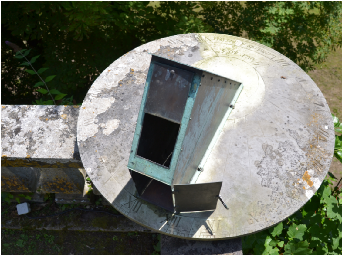
Fig 2 : Vue du dessus. Les deux arêtes de la chambre méridienne font office de style polaire pour le cadran horizontal.
